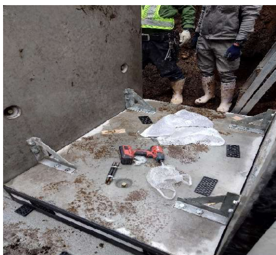
側壁②の設置状況
