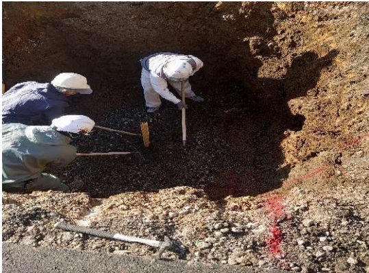
基礎碎石敷き均し状況
