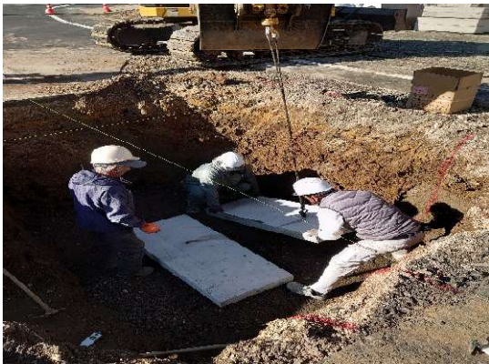
基礎版の設置状況
