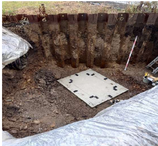
墨出し・ライナープレート設置
