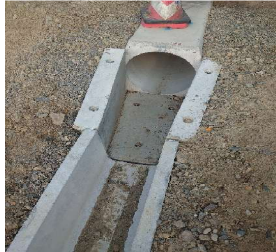
庄毛地区経営体育線基盤整備 1 工区ほ場整備工事
