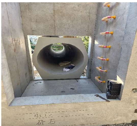
管渠工接続状況（S C集水桝内側）
