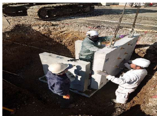
妻壁（１）設置状況
