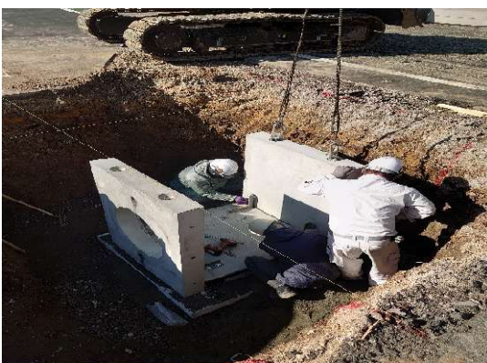
側壁（２）を側壁（１，２）に固定
