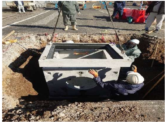
床版設置状況
