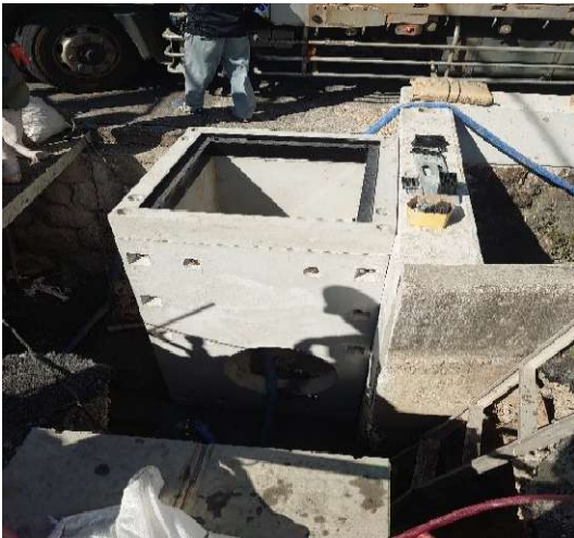
都市計画道路朝倉駅針木線防災・安全交付金工事
