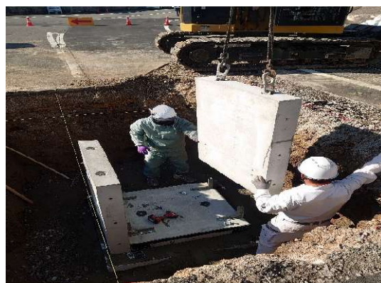
側壁（２）をインバートに仮固定
