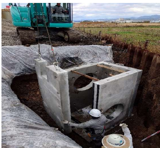
妻壁②設置状況
