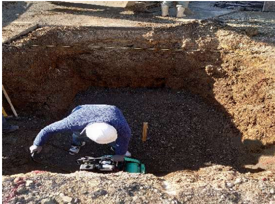
基礎碎石転圧状況
