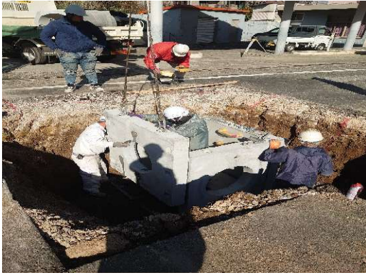
妻壁（２）設置状況
