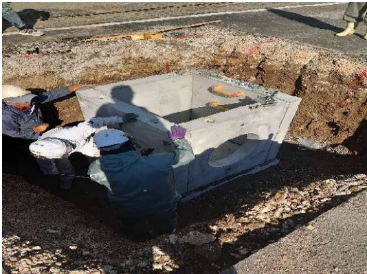
妻壁（２）を側壁（１，２）に固定
