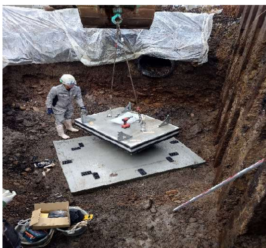
インバート部材設置状況
