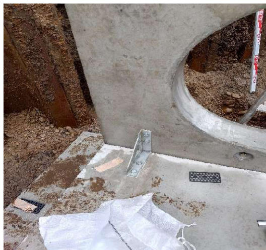
側壁①の設置状況
