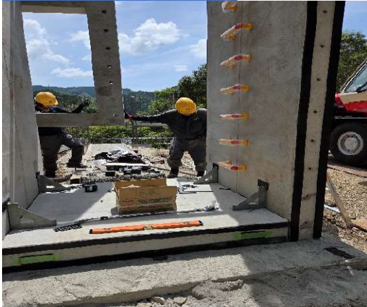
妻壁（1）設置状況
