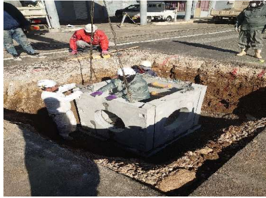
妻壁（２）設置状況
