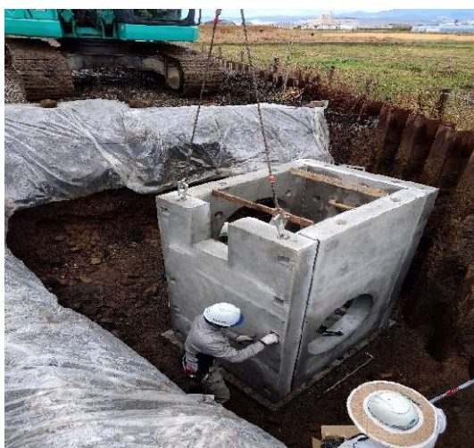
設置後ボルト締め付け
