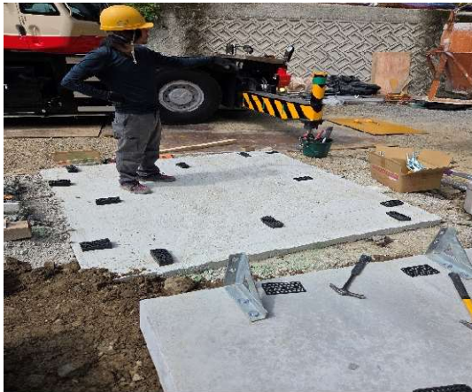
ライナープレート設置
