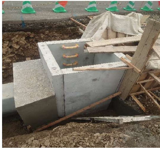
令和4年度 国道56号小黒ノ川視距改良外工事
