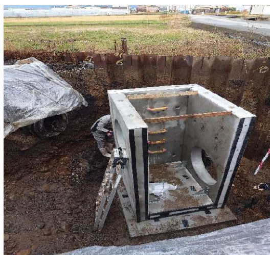
妻壁①設置状況
