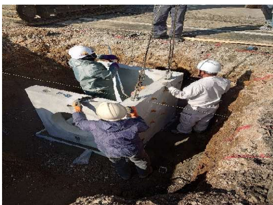
妻壁（１）を側壁（１，２）に固定
