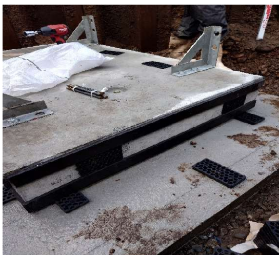
インバート部材設置後、集水桝内寸をライナープレートにて調整して下さい。
