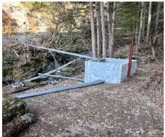
越知面地区あめご養殖場施設整備工事
