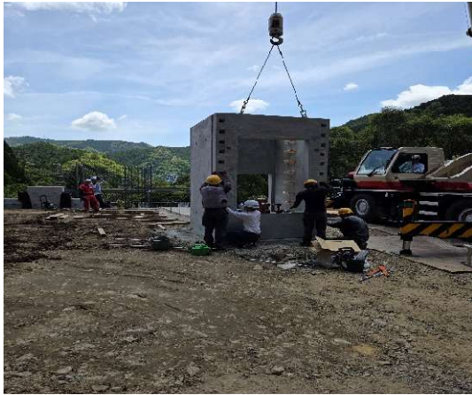
妻壁（2）設置状況
