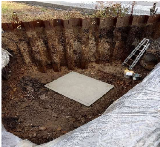
基礎コンクリート打設
