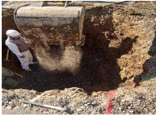
基礎碎石投入
