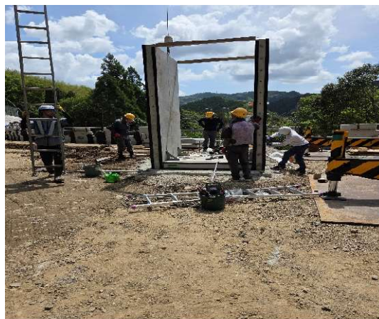
間隔保持剤設置
