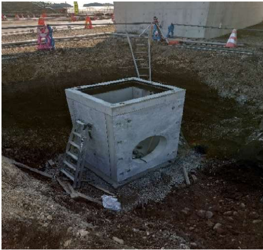
令和3-4年度 南国安芸道路西野地区改良第4工事
