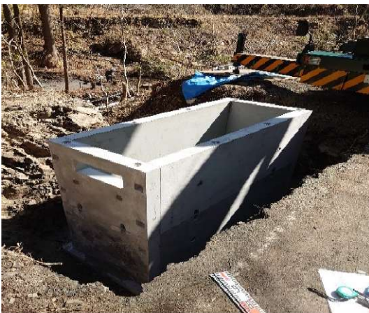
越知面地区あめご養殖場施設整備工事
