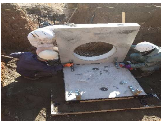
側壁（１）をインバートに仮固定
