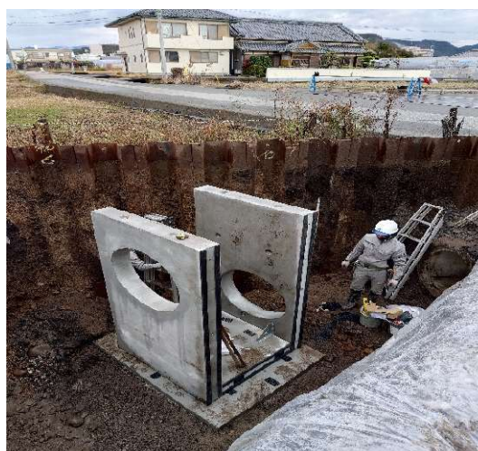
側壁①・②設置後、水膨張止水テープを内外側に張り付けて下さい
