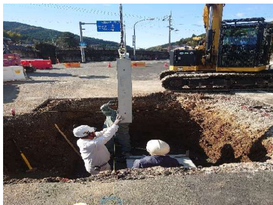
側壁（１）設置状況
