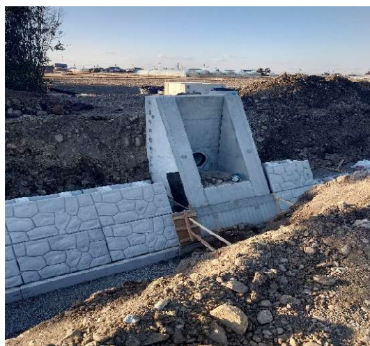
市道新道線改良工事
