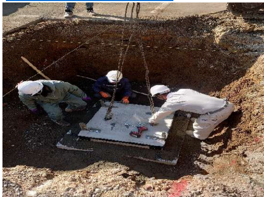
インバート設置状況
