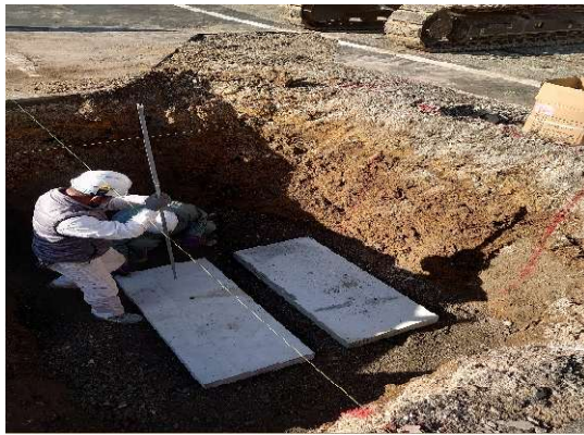
基礎版設置後高さ確認
