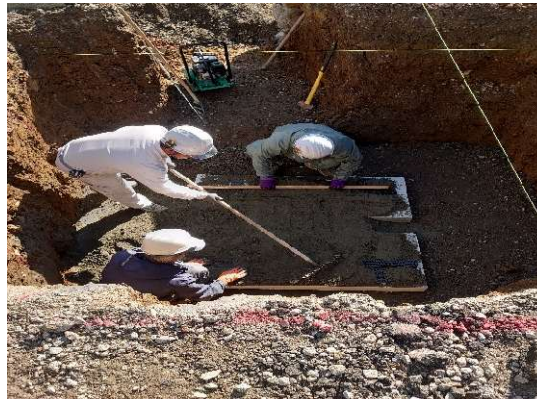
敷モルタル敷き均し状況
