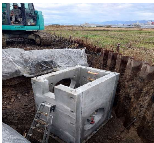
上部蓋版用差筋設置
