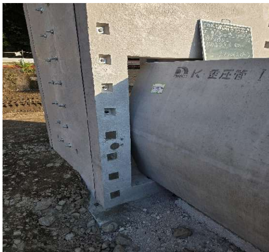
管渠工接続状況（S C集水桝外側）
