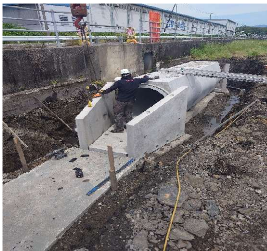
浜改田西部工区区画整理工事
