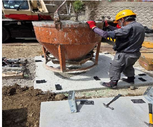
敷モルタル敷き均し
