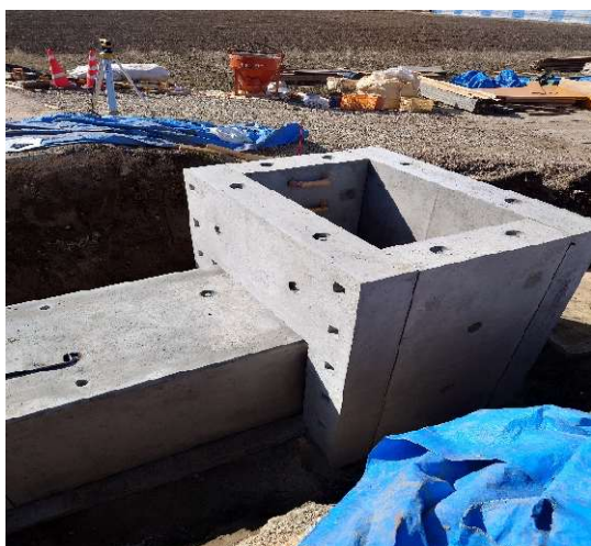
上井川通水路整備工事
