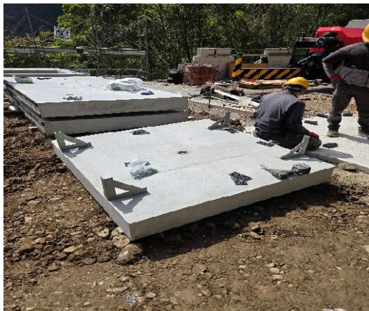
インバートに仮固定治具設置
