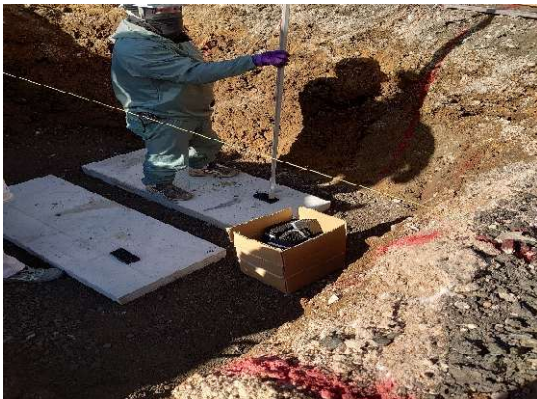
ライナープレート設置状況
