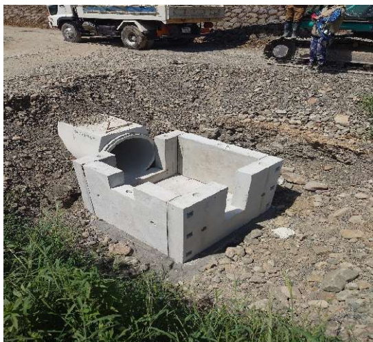
庄毛地区経営体育線基盤整備2工区ほ場整備工事
