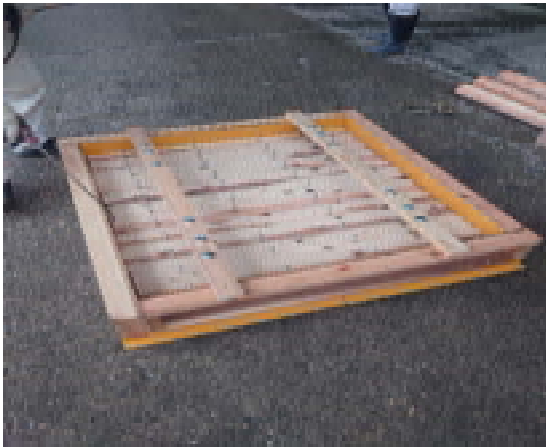
型枠に間伐材を並べる
