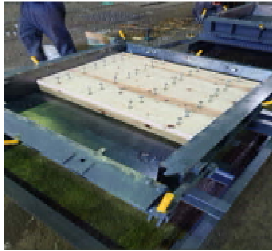
型枠に間伐材を並べる
