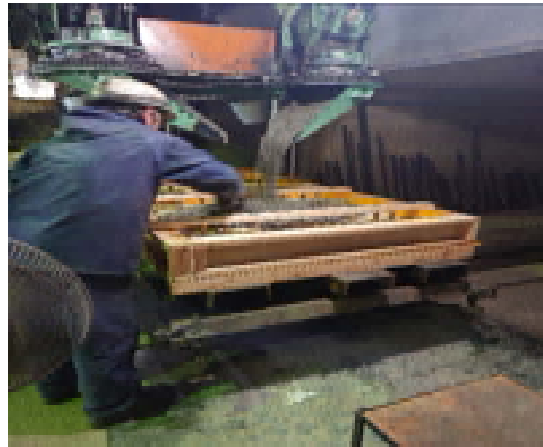
コンクリート打設
