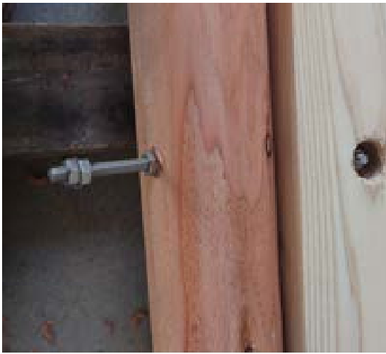
間伐材に貫通穴を明けボルトを挿入
