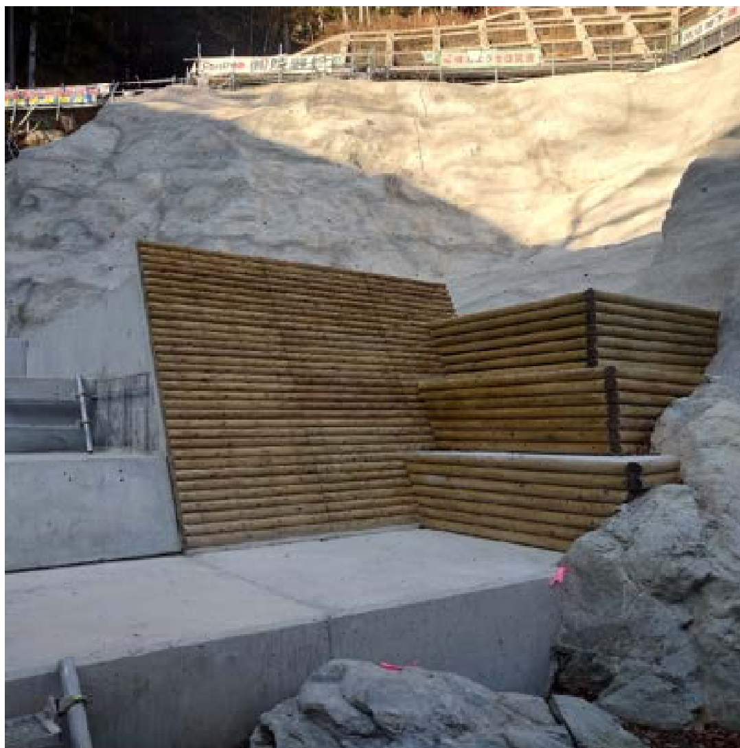
おもわれ谷堰堤工事
