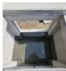
S y 樹ベース漏水実験
