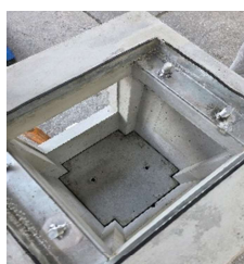
S y 樹ベース設置状況
