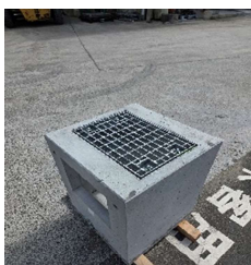
鋼製蓋設置した S y 樹
