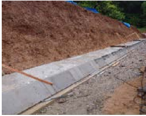
県道土佐佐川線防災・安全交付金工事
