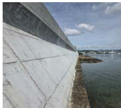
高知港海岸（西孕地区）高潮対策工事
