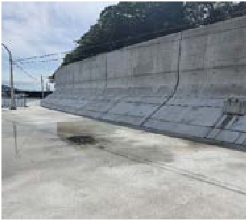
高知港海岸（横浜工区）高潮対策工事
