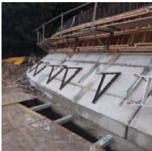
高知港海岸（横浜工区）高潮対策工事
