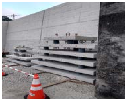
現場に搬入されたK O パネル（塩害型）
