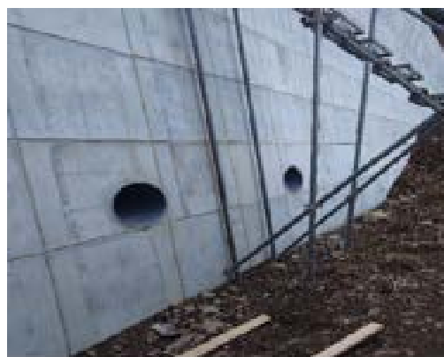
影野復旧治山工事
