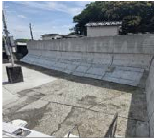
高知港海岸（横浜工区）高潮対策工事
