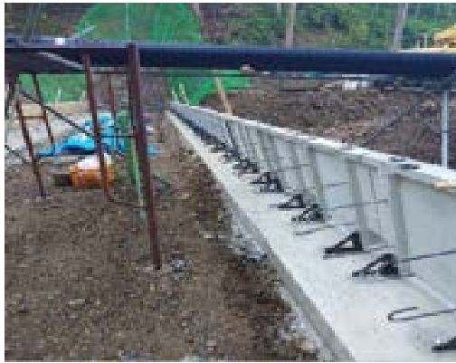
影野復旧治山工事
