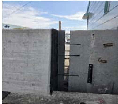
高知港海岸（港町地区）高潮対策工事
