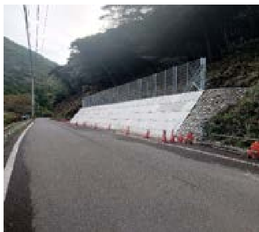
国道493号道路改築工事
