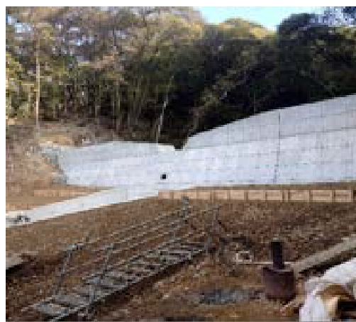
鎌田林地荒廃防止工事
