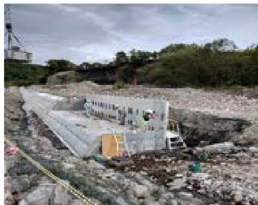
大笹床固群工事
