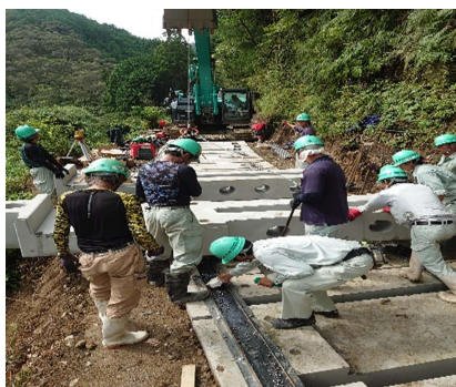
ロードプラス設置
