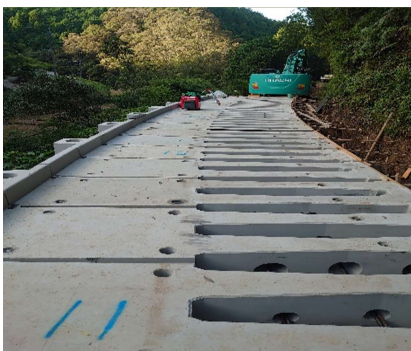
ロードプラス設置完了
