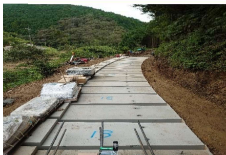
ロードプラス台座ブロック設置
