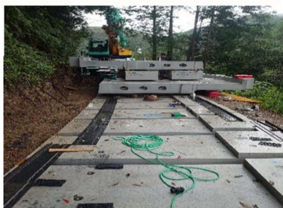
スライド鋼材設置状況
