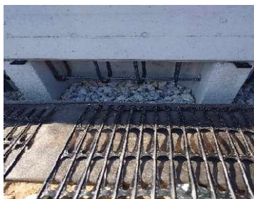
フック筋設置状況
