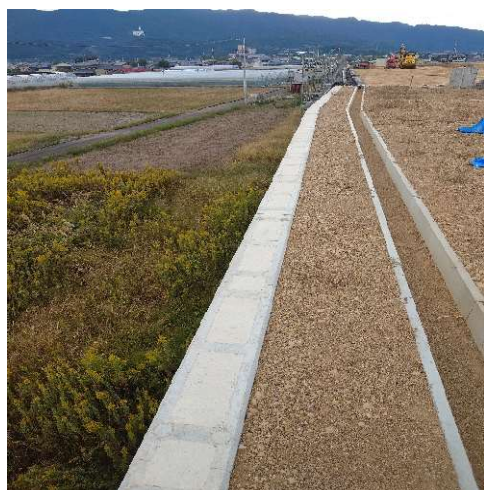
令和3-4年度 南国安芸道路下井西第6工事
