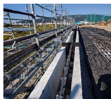
フック筋設置状況
