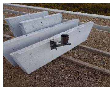
専用足場取付状況
