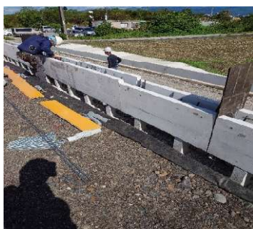
笠コンウォール設置状況
