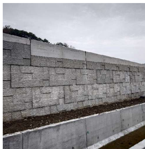
令和5年度 窪川佐賀道路見付改良工事
