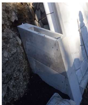
製品を2段設置した状況
