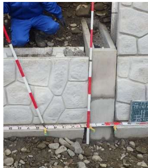
ブロックを2段設置して 生コン打設した状況
