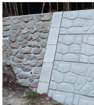
完成した状況
