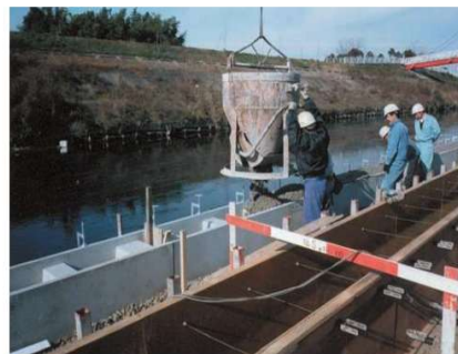
7. コンクリート打設
