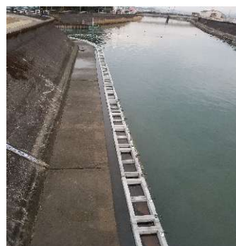
国分川高潮対策工事
