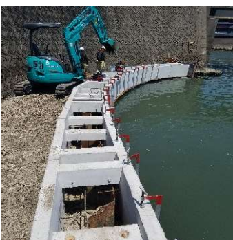
赤岡漁港水産基盤ストックマネジメント工事
