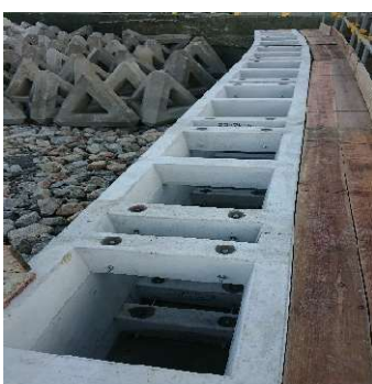
初崎堤防改良工事
