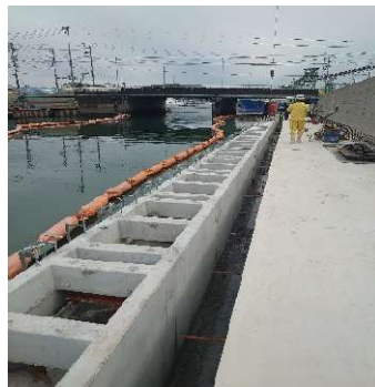
高知港海岸高潮対策工事
