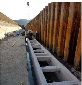
下田川高潮対策工事
