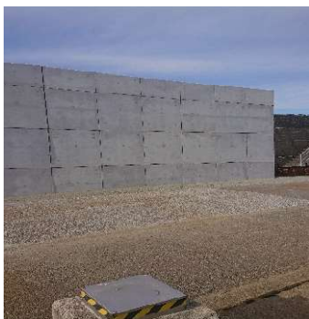
宇佐漁港海岸高潮対策工事
