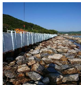
初崎堤防改良工事
