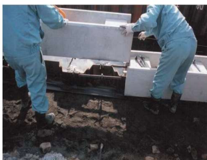
3. 幅止め金具の取り付け
